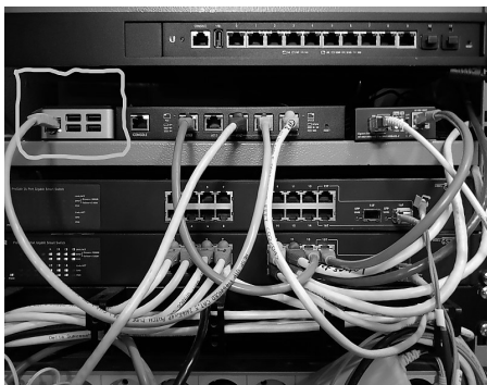
Bild på min RaspberryPi som Pi-Hole DNS server.
