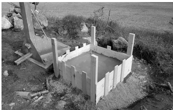
Rejäl övergjutning, gängstängerna är borrade och fästa i berget.
