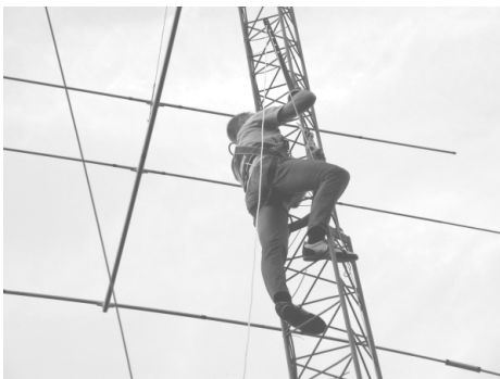
Förberedelser inför kommande tester. Lars/BJL i 18 metersmasten i färd med att höja dipolfästet till högsta läge!
