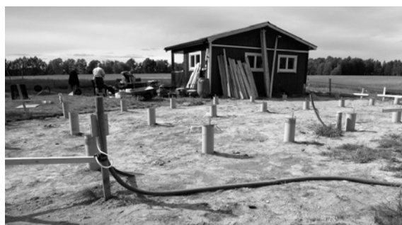
Klart för gjutning av plintar.
