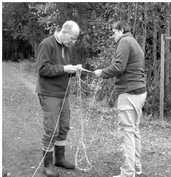
Antennuppsättning ingår i kursen. Tomas och Åsa försöker att inte trassla in sig. Här monteras en dipol för 40 m.
