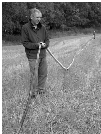
Att trä en 7/8 koax med 30 mm diameter genom en 50 mm, 50 m lång slang, gick som smort, speciellt om man smorde kabeln lite. Ingemar SYQ och Leif DSG.
