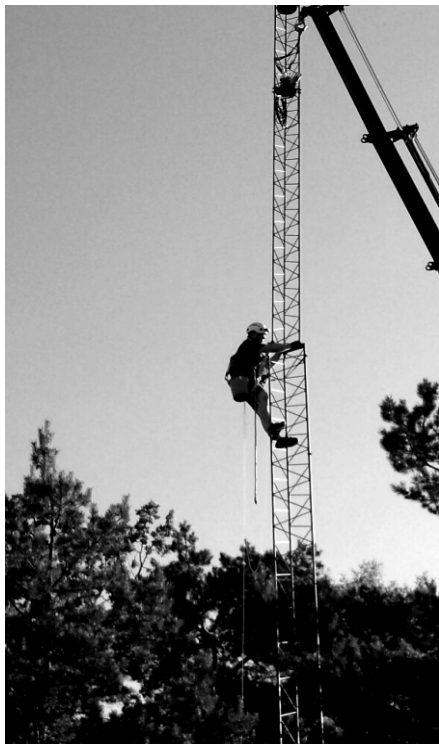
Jocke WED sköter mastklättring och skruvjobb...
