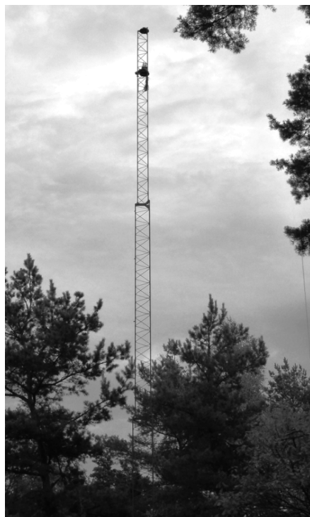
Efter uppsättning reser sig masten ståtligt över träden. På plats sitter rotorn "Big Boy" från Prositek. Nu fattas bara antenn.
