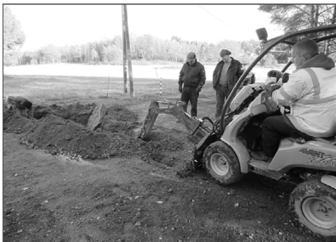
Johan Thid, SAØBMC ställde upp med en liten smidig grävare. Här gräver man genom vägen.
