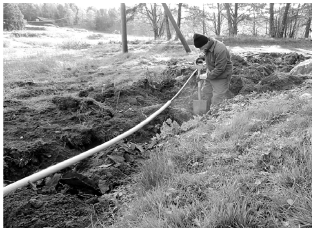
Kabel förläggs i marken. Leif DSG gräver.
