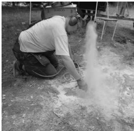
Renblåsa hålen, sen gjuta fast bultarna.
